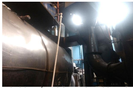
FOTOGRAFÍA 2. SISTEMAS DE CONTROL
